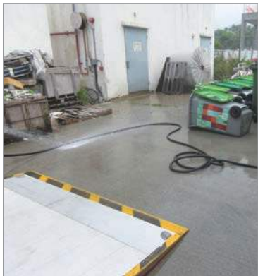
使用流動灑水器減低塵土飛揚
