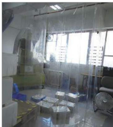
安裝隔音簾，以控制聲浪
