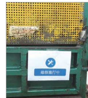
加上告示牌以示待修
