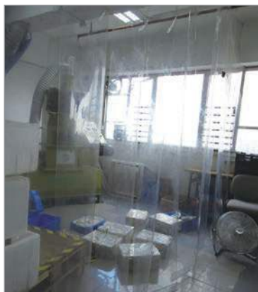
安裝隔音簾，以控制聲浪
