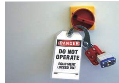
進行電力工程前掛上警告牌
