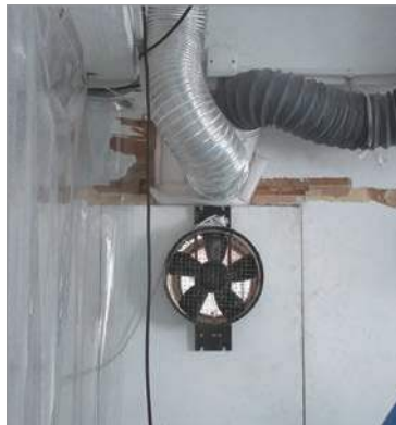
安裝抽風系統減低 室內空氣污染
