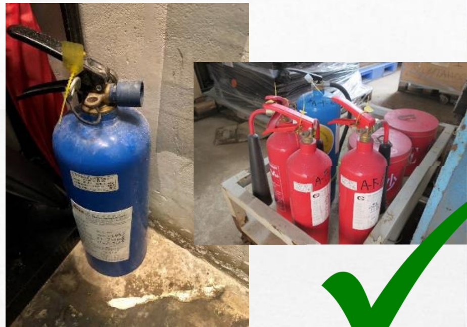
提供足夠及合適的滅火設備
